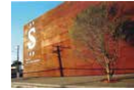
426 AUTOR NÃO IDENTIFICADO Sede Banco Santos - Fachada com árvore Foto cor sobre papel / Vincos. Lance inicial R$ 200,00
